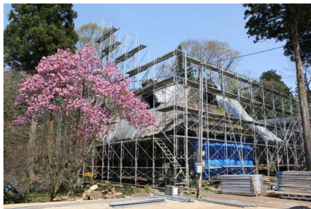
覆屋設置が始まった旧木下家
